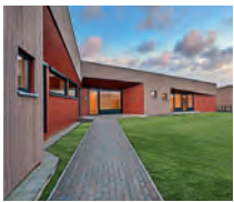
Wiederaufbau und Neubau Waldorfkindergarten und Waldorfschule, Wöhrden Architektur: JEBENS SCHOOF ARCHITEKTEN BDA TGA: Ingenieurbüro Busch, Husum Statik: Ingenieurbüro Thomas Stolte, Husum Brandschutz: Ingenieurbüro Andreas Grap, Schalkholz Foto: Alexander Zachen
