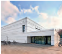
Energetische Sanierung und Modernisierung Dreifeldsporthalle, Schulzentrum Eilun-Feer-Skuul, Wyk auf Föhr Architektur: andreas schneider architekten GmbH & Co. KG Planung und Durchführung: ARGE „Wyk“ andreas schneider architekten GmbH & Co. KG iwb Ingenieurgesellschaft mbH Foto: Caspar Sessler
