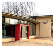
Neubau einer Naturwerkstatt, Travemünde Architektur: Architekturbüro Menzel Statik: Cornelius Back, Lübeck Foto: Mattias Menzel
