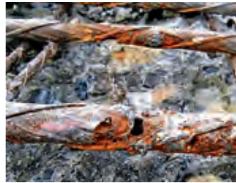
Durch Tausalzeintrag verursachte Korrosion bei einem Betonbauteil mit konventioneller Stahlbewehrung | Prof. Görtz Eingebaute Basaltfaserstabbewehrung in Testfeld | Dt. Basaltstab GmbH
