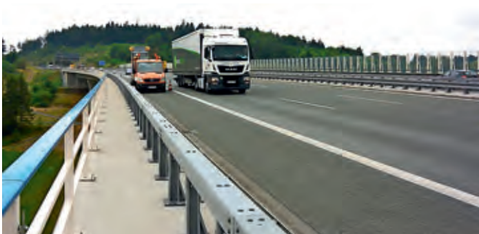
Brückenkappe einer Autobahnbrücke | Prof. Dauberschmidt
