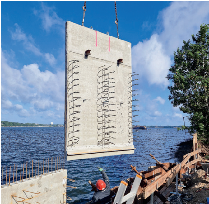
Basaltfaserstabbewehrung bei Instandsetzung Uferwand Hasselfelde | Foto: Stephan Görtz
