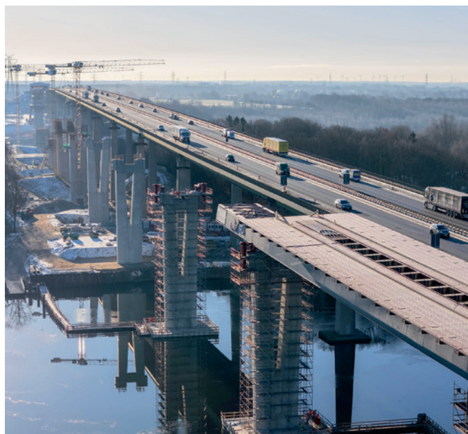
Mithilfe des Taktschiebeprozesses wächst das imposante Bauwerk Stück für Stück. | Foto: DEGES/Wohlfromm
