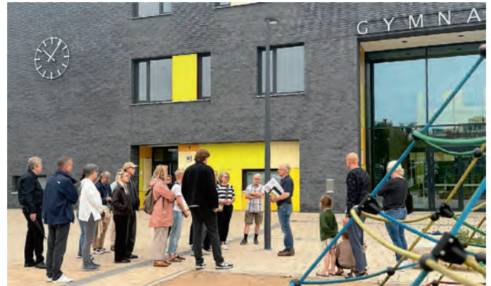
Gymnasium Mühlberg, Bad Schwartau | efs architekten + stadtplaner
