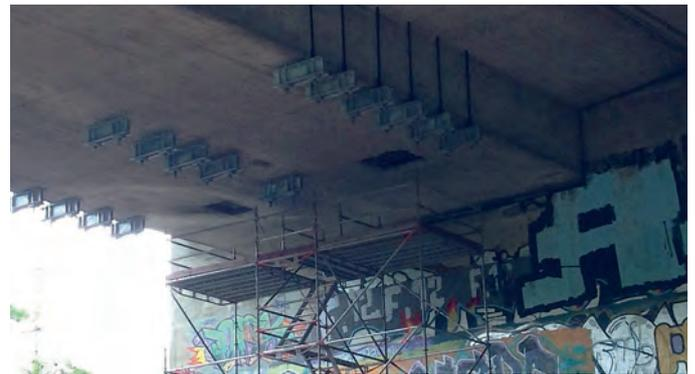
Ertüchtigung der Querkrafttragfähigkeit durch extern angeordnete Bewehrung (hier Brücke Rettelmühle im Zuge A45) | Prof. S. Görtz
