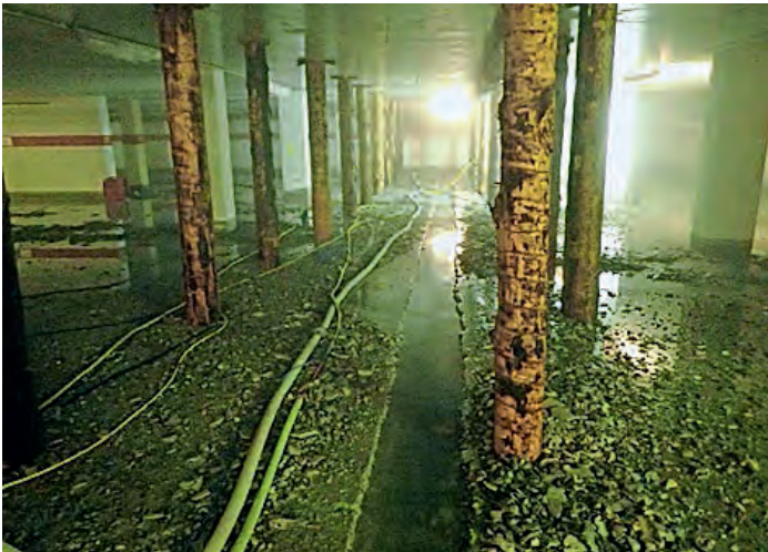
Herkömmliche Instandsetzung einer Tiefgaragenbodenplatte mit Betonabtrag durch Höchstdruckwasserstrahlen | Prof. Dauberschmidt
