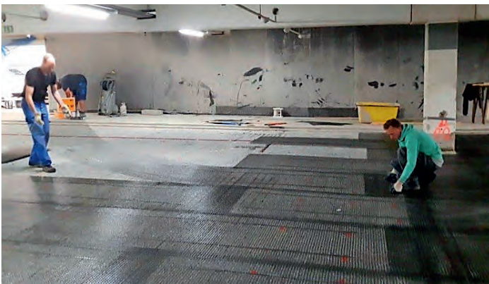
Verstärkungsmaßnahme in einer Tiefgarage mit textilen Carbongelegen | Prof. Dauberschmidt
