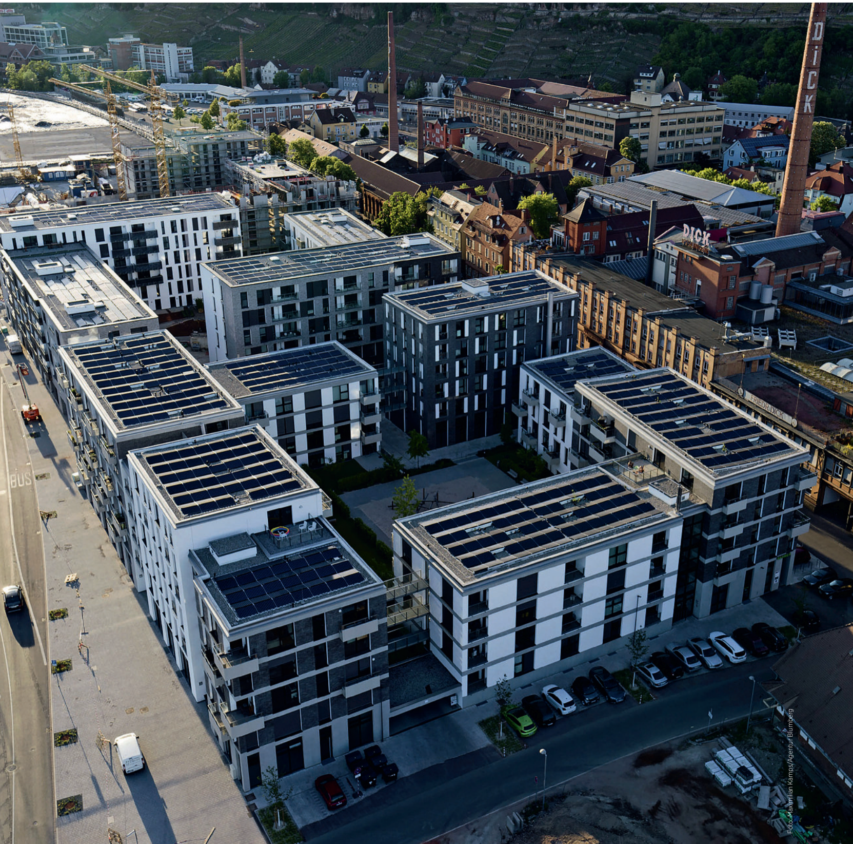
Klimaneutrales Stadtquartier „Neue Weststadt“ in Esslingen
