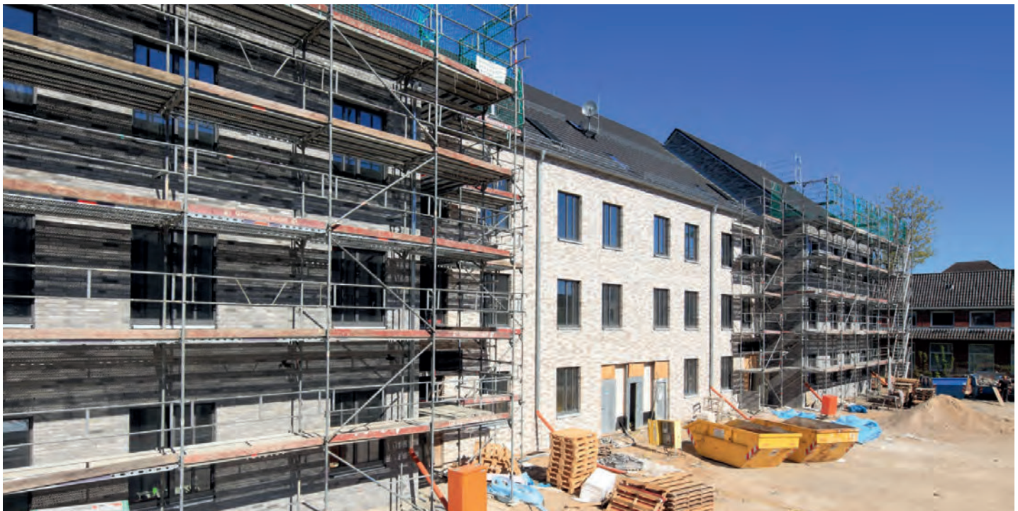
Baustelle Unterkunftsgebäude Marinestützpunkt Kiel | © GMSH
